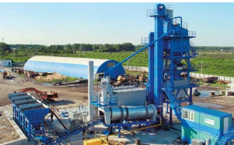
Асфальтосмесительная установка АС-100 в городе Ялуторовск Тюменской области
