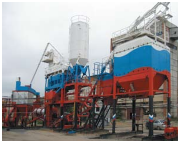
Установка РТ-50, смонтированная без фундамента
