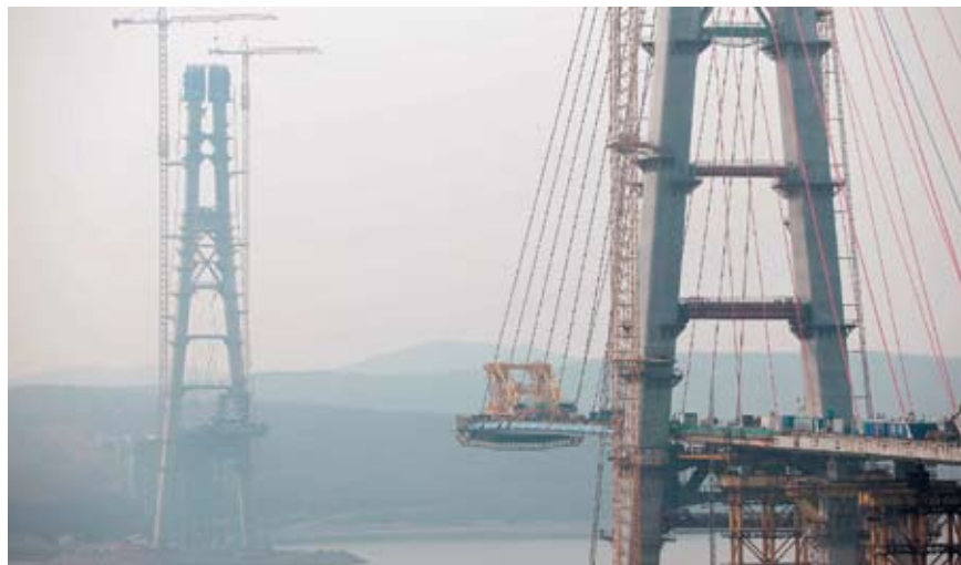
СТРОИТЕЛЬСТВО МОСТА НА ОСТРОВ РУССКИЙ.
